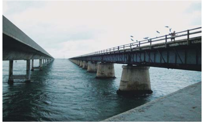
【写真2】マイアミからキーウエストまで260kmをサンゴ礁の島伝いに42の橋を渡る。右側が初期の鉄道橋で現在は遊歩道、左側が新たに建設された現在の車道橋。(往復8時間の日帰りバスツアーはかなりハード)
