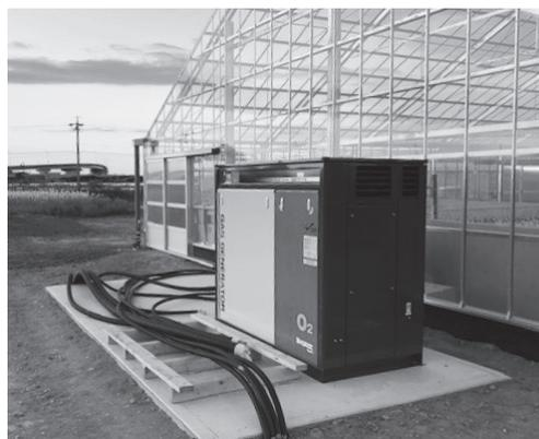
写真5 養鰻場に設置された完全屋外仕様のGENE-BASEシリーズ機種
