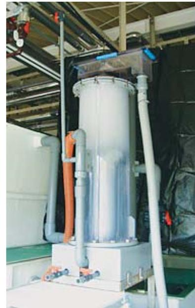
図3 開発した泡沫分離装置
